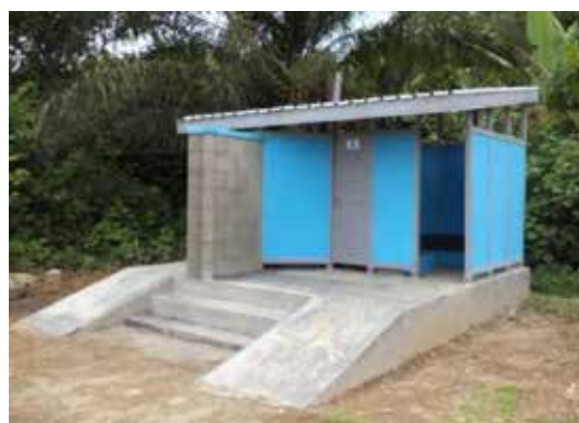
Ilustración 10: Servicios sanitarios con acceso de gradas y rampas. (Fuente: UNICEF)
