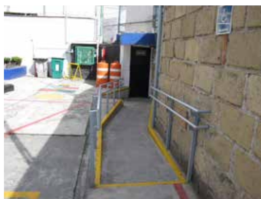
Ilustración 16: Rampa de ingreso a una escuela. (Fuente: Janett Jiménez)
