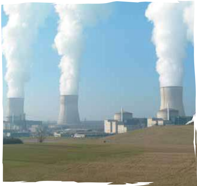
Las chimeneas de las fábricas son altamente contaminantes, para los trabajadores y los habitantes de comunidades aledañas.
